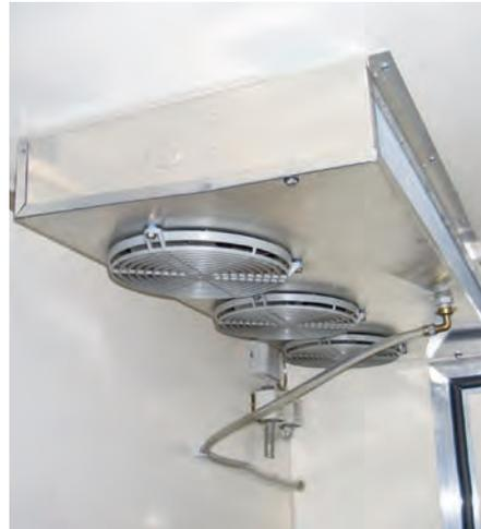
Abbildung 10: Sauberes Kühlaggregat in einer mobilen Kühlzelle
